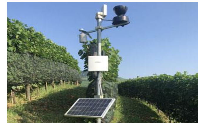
Pannello FV per centralina meteo
